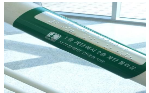
계단 난간 점자 안내 표지판 설치
